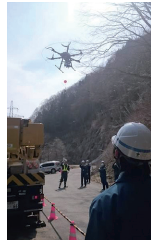
ドローンを利用した通線作業
