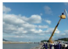
光ケーブルをクレーンで敷設
