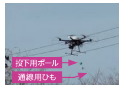
2016年12月 千葉県君津市 光ケーブル通線作業
