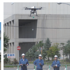
ドローンによるケーブル通線作業
