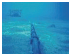
水底ケーブル 800km
