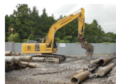
重機により破砕される電柱
