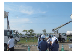
応急復旧ケーブルの布設作業
